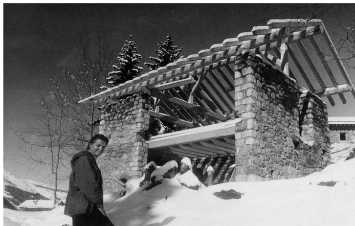
Charlotte Perriand devant un de ses chalets en construction, 1960.
